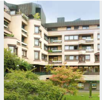
Stuttgart-F Feuerbach, Burgenlandzentrum , multifunktionales Gebäude mit Bücherei, Praxen und Pflegeheim, WEG- und Mietwohnungsverwaltung
